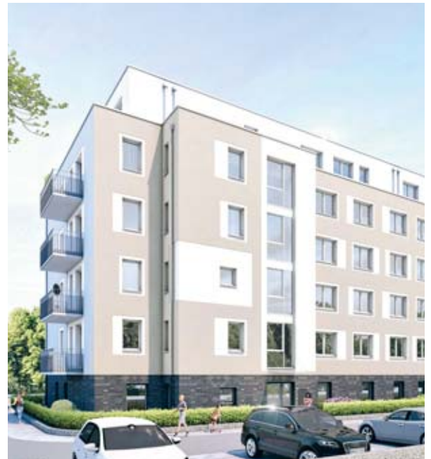
An der Heinrich-Hoerle-Straße startet Veedel Energie.
